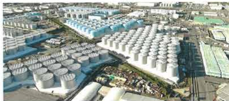
1000基のタンク。すでに9割が使用されている。
